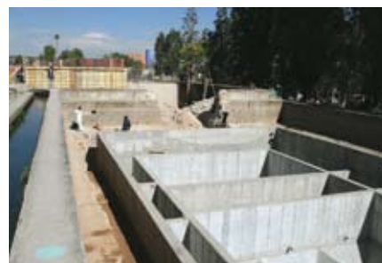
Avance de obra de la Planta
