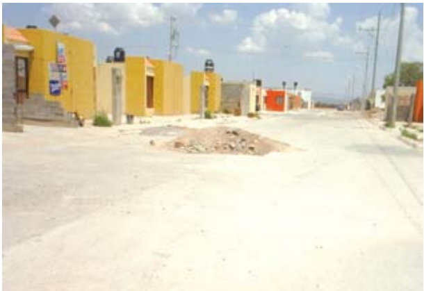
Revisión de infraestructura, Fracc. Villas del Sol
