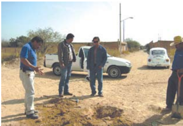
Revisión de colector de drenaje en Fracc. Los Azahares
