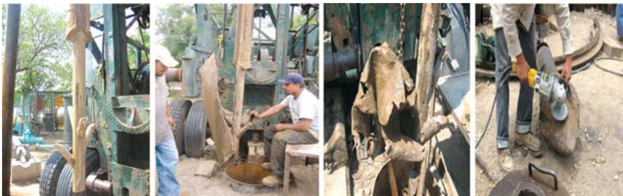
Extracción del ademe para poder profundizar el pozo Juan Sarabia
