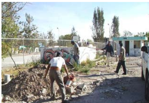
Limpieza General de Pozos (Pozo Salk )
