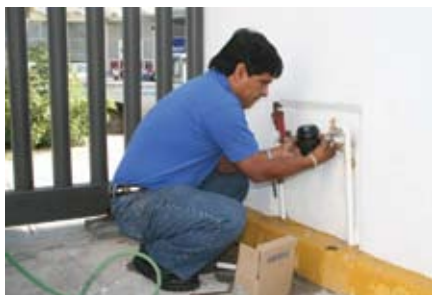
Instalación de medidores
