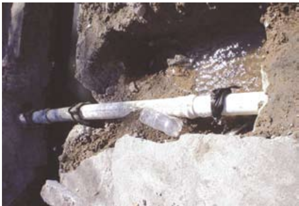
Revisión red de agua potable, Callejón del Barro
