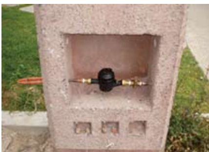
Instalación de medidores
