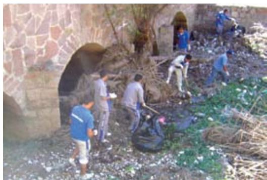
Limpieza a la presa San José
