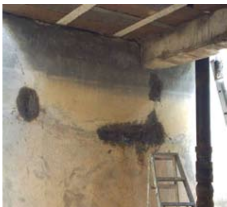
Acabados interiores, exteriores de casetas y pilas de almacenamiento de agua potable
