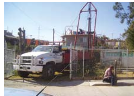
Rehabilitación de pozos
