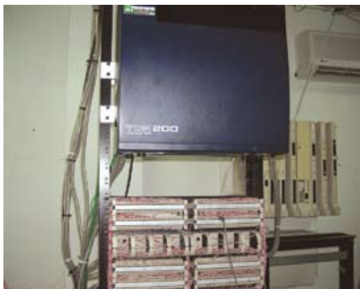
Mantenimiento del conmutador
