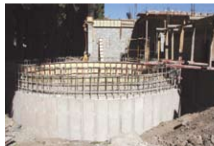
Construcción del tanque espesador de lodos
