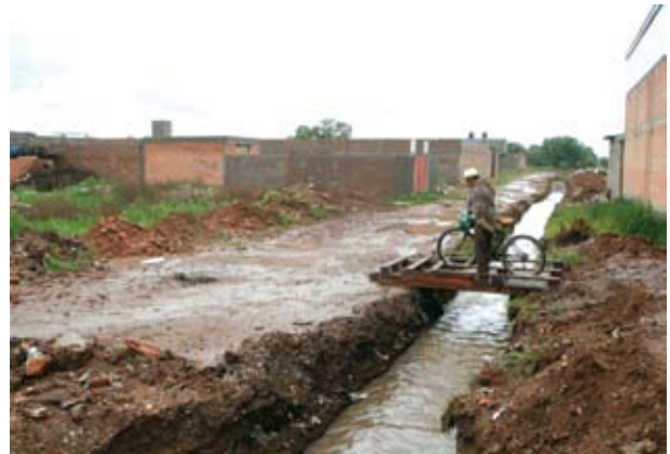
Zanjas para desalojar el agua pluvial, Col. Los Molinos
