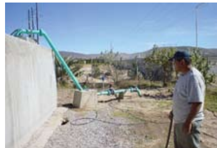
Obras de equipamiento, rehabilitación y regulación del sistema de agua potable en Cerro de San Pedro
