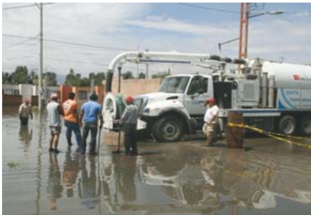
Limpieza y desazolve en Praderas del Real
