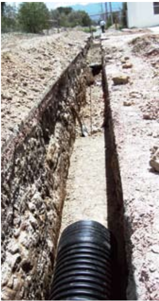
Revisión red de drenaje en Fracc. Villas del Sol
