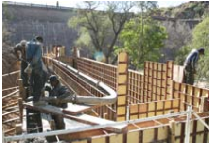
Construcción de la planta de pretratamiento (presa San José)
