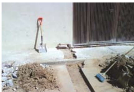
Sustitución de tomas domiciliarias
