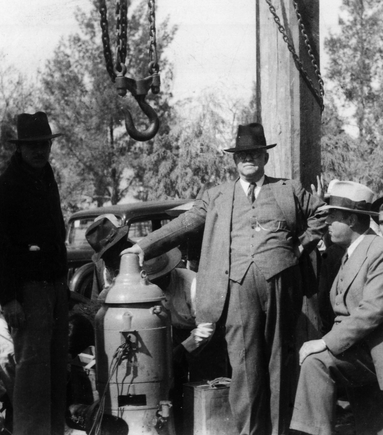
Francisco de P. Cabrera en las obras de perforación del pozo frente al internado
