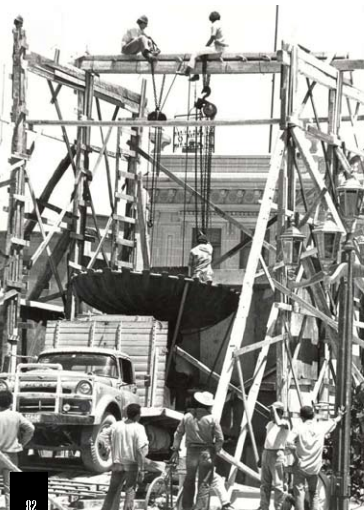
Maqueta de la fuente “De los Pescaditos”, que se colocó en la Plaza del Carmen en 1973. Abajo, instalación de dicha fuente, Obra de Joaquín Arias.
