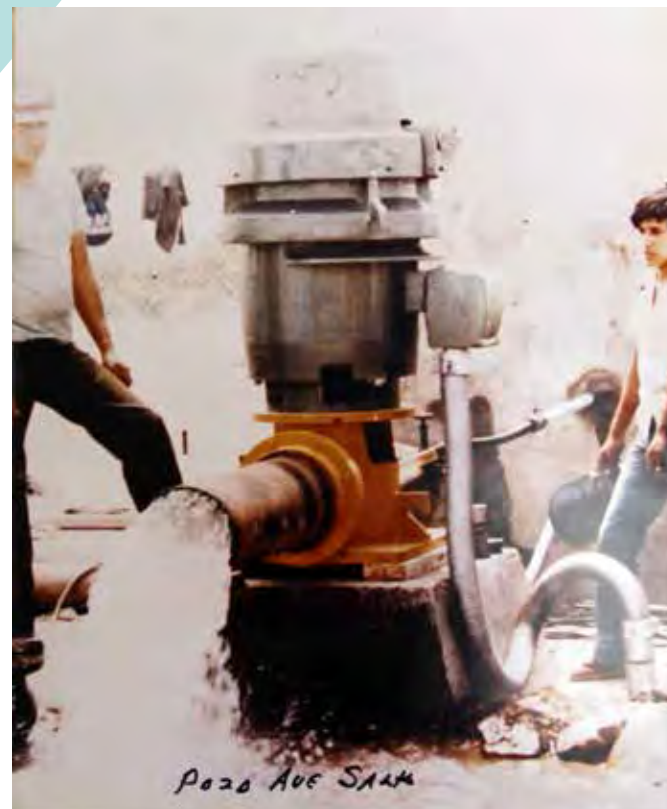
Aforo del pozo Av. Salk.
