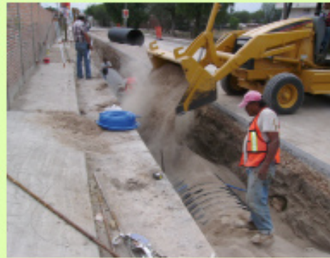
Construcción de colector de aguas residuales Pedroza-Sauzalito y rehabilitación de cruce con ferrocarril en zona norte de San Luis Potosí.
