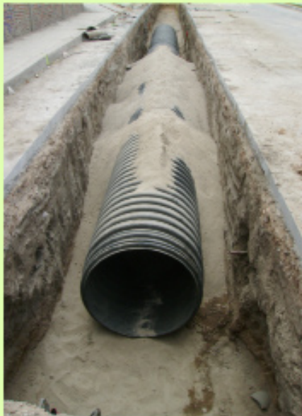
Construcción de colector de aguas residuales Pedroza-Sauzalito y rehabilitación de cruce con ferrocarril en zona norte de San Luis Potosí.
