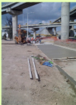
Construcción de colector pluvial Av. México, municipio de San Luis Potosí.
