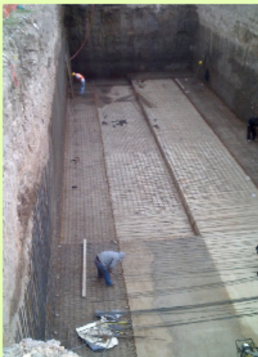
Construcción de cárcamo de bombeo de aguas pluviales en el dren Española-Santiago, municipio de San Luis Potosí.
