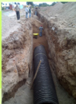
Construcción de colector pluvial Los Silos-Los Molinos (1a etapa).
