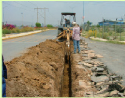
Construcción de cárcamo de bombeo, línea de conducción de agua potable y tanque de regularización para entrega de agua en bloque a la Col. Lomas de La Virgen.
