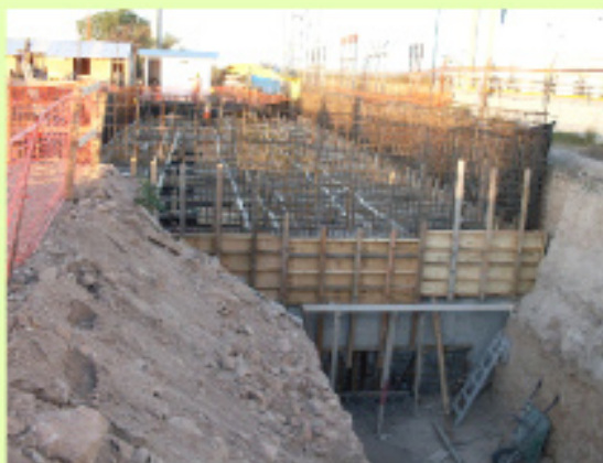
Construcción de cárcamo de bombeo de aguas pluviales en el dren Española-Santiago, municipio de San Luis Potosí.
