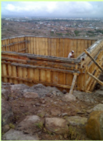
Construcción de cárcamo de bombeo, línea de conducción de agua potable y tanque de regularización para entrega de agua en bloque a la Col. Lomas de La Virgen.
