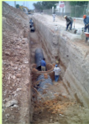
Construcción de cárcamo de bombeo, línea de conducción de agua potable y tanque de regularización para entrega de agua en bloque a la Col. Lomas de La Virgen.
