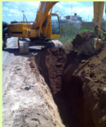
Construcción del colector de aguas residuales Periférico Norte, municipio de San Luis Potosí.
