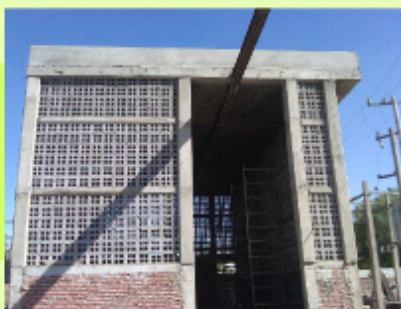
Rehabilitación y modernización de la estación de bombeo San Leonel, municipio de S.L.P.
