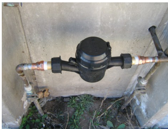
Instalación de 10,000 medidores de agua potable en diversas colonias de la zona metropolitana de San Luis Potosí.
