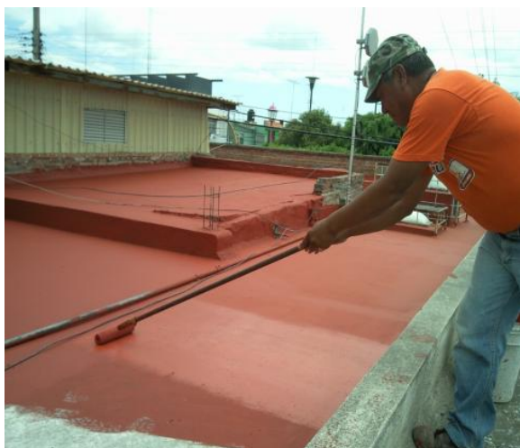
Impermeabilización de Himalaya
