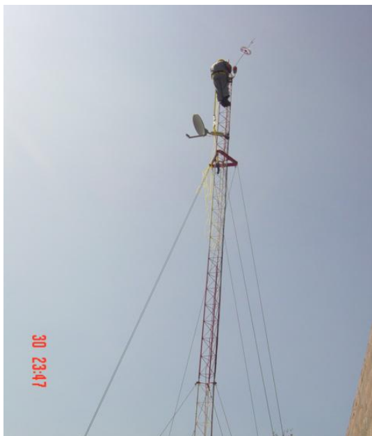
Colocación de pararrayos
