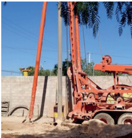
Perforación del pozo Mezquital III Nvo.
