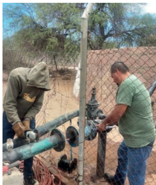
Instalación de Macromedidor nuevo en pozo El Jaralito
