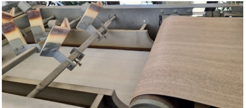
Ilustración 5. Nueva banda transportadora instalada en Deshidratador de lodos
