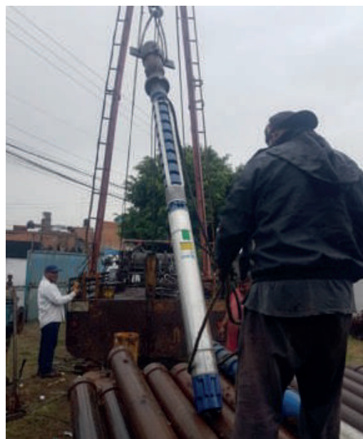
Maniobra de instalación de bomba sumergible por personal Contratista en pozo Dalias
