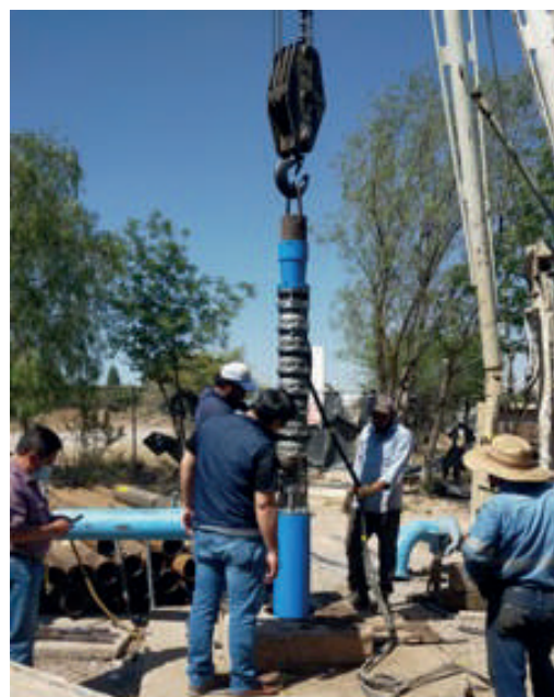
Instalación de electrobomba sumergible en pozo Periférico Norte III.
