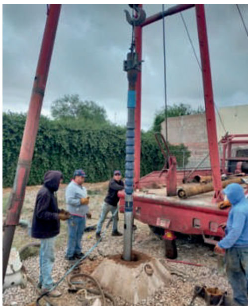
Maniobra de instalación de bomba sumergible en pozo Puerta Real con personal del Organismo
