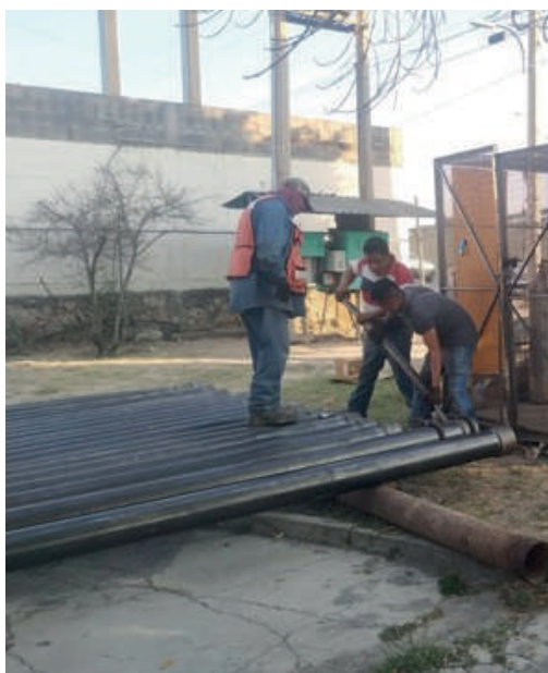
Instalación de tubería de columna nueva en pozo Prados Glorieta
