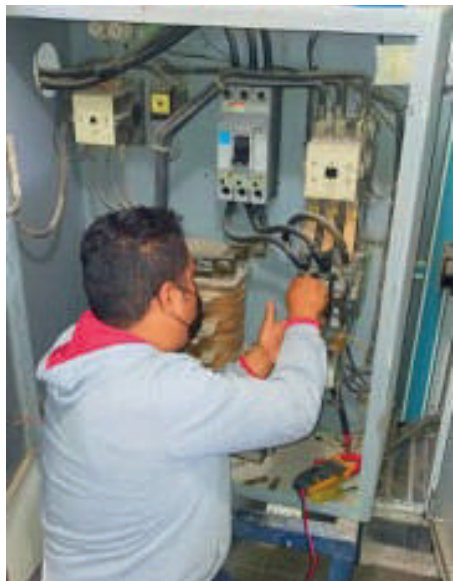
Reparación de falla en arrancador eléctrico a tensión reducida
