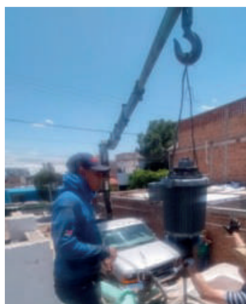
Maniobra de instalación de bomba vertical en rebompeo de pozo Los Fresnos.
