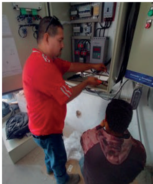
Cambio de arrancador eléctrico en rebombeo Puente Pemex.
