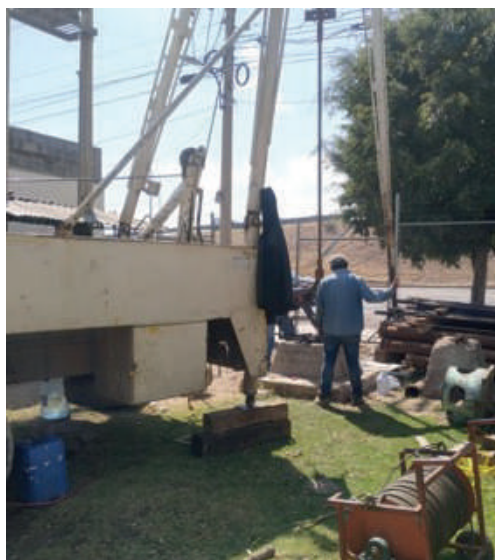
Maniobra de pesca en pozo Prados Glorieta
