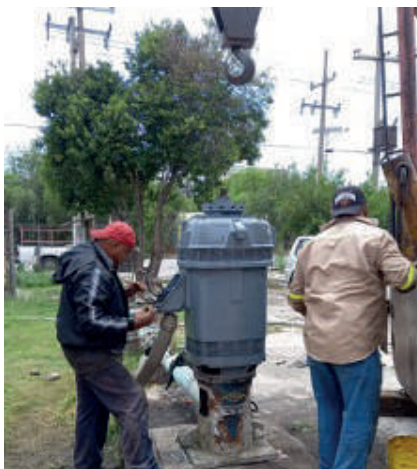
Maniobra de instalación de bomba vertical en pozo Bomberos
