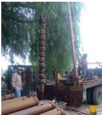
Maniobra de extracción de bomba vertical en pozo Termal V.
