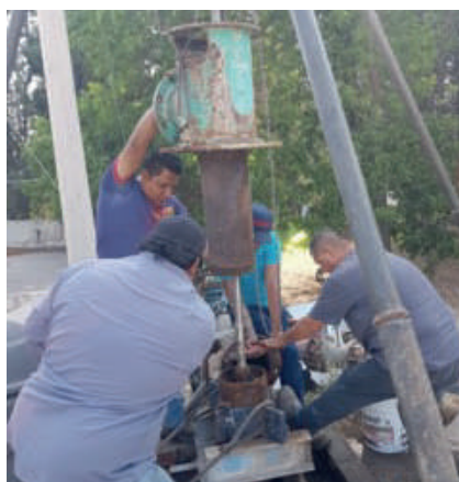
Maniobra de extracción de bomba vertical en Rebompeo Nereo.
