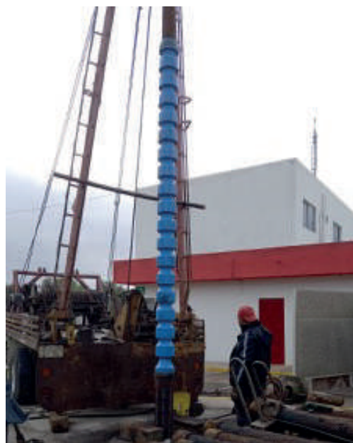
Instalación de cuerpo de tazonos en pozo Bomberos
