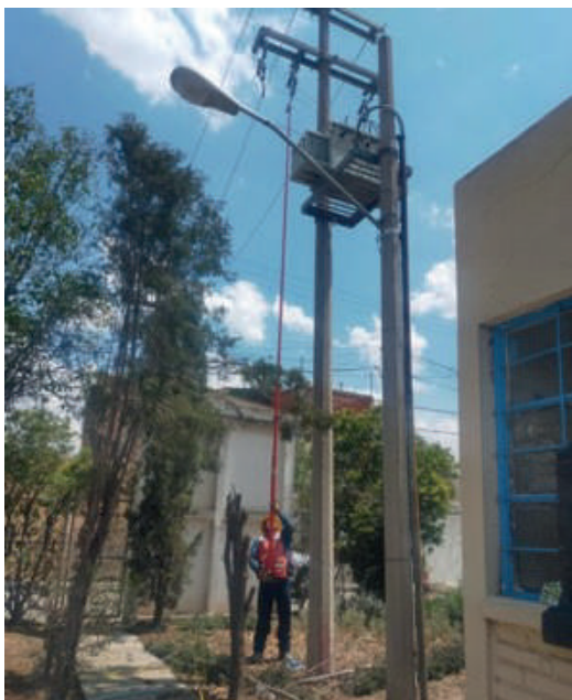
Rehabilitación de instalación eléctrica en pozo Pedroza II
