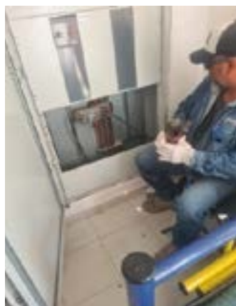
Reparaciones de cableado en centros de carga
