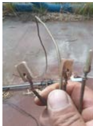
Mantenimiento a electrodos del automático del rebombero Himalaya
