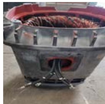
Reparación de motor vertical del pozo huerta del ángel.
