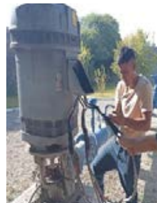
Mantenimiento a cableado del motor vertical del pozo Mayamil.
