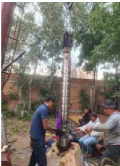
Instalación de electrobomba en el Pozo Coronel Espinoza.
