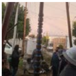
Maniobras de desinstalación bomba tipo turbina en el pozo de San Francisco de Asís, el cual se cambio por bomba sumergible.
