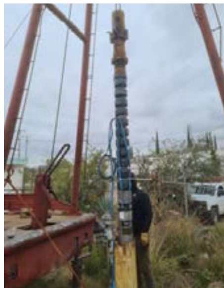
Instalación de electrobomba sumergible en el Pozo Arboledas del Aguaje.
