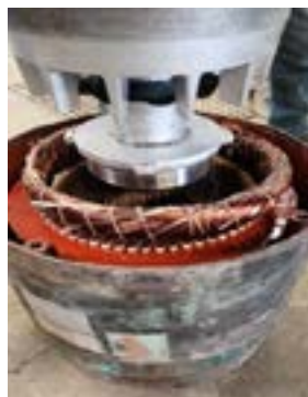
Reparación de motor vertical del rebompeo filtros.
