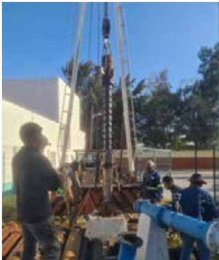
Instalación de electrobomba sumergible en Pozo San Antonio Infonavit.
