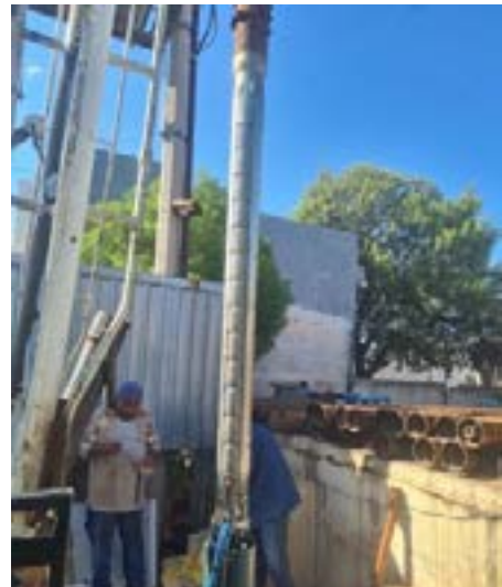
Instalación de electrobomba sumergible Pozo San Ángel
