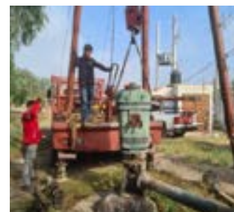
Maniobras de desinstalación bomba tipo turbina en el pozo de San Francisco de Asís, el cual se cambio por bomba sumergible.
